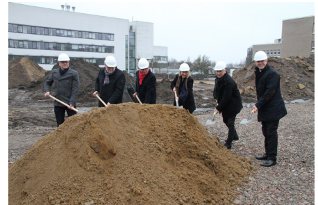
Abbildung 7 Spatenstich mit Minister Remmel
